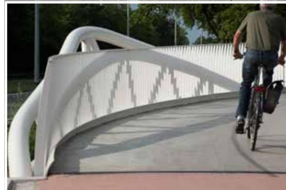
Arteum Architects, Grontmij en CSM tot een sterk architectonisch concept en een efficiënt ontwerp met een beperkte life cycle cost. De vorm van de brug is minutieus afgestemd op de krachten die ze ondergaat. De bogen en de vakwerken zorgen er samen voor dat (de sterke van) iedere kilo staal optimaal benut wordt. Het visuele patroon dat zo ontstaan is, heeft dus vooral met de krachtverdeling te maken, en niet zozeer met de beoogde uitstraling.
