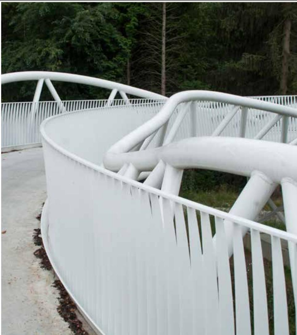
realisaties hebben we dit project toch tot een goed einde kunnen brengen. Een aanzienlijk deel van onze omzet genereren we immers via het maken van achtbanen, en qua constructie – twee slanke buiselementen die slingeren door de ruimte – leunt deze brug daar dicht bij aan. De staalcomponenten zijn stuk voor stuk gemailleerd en afgewerkt met drie lagen witte verf.”
