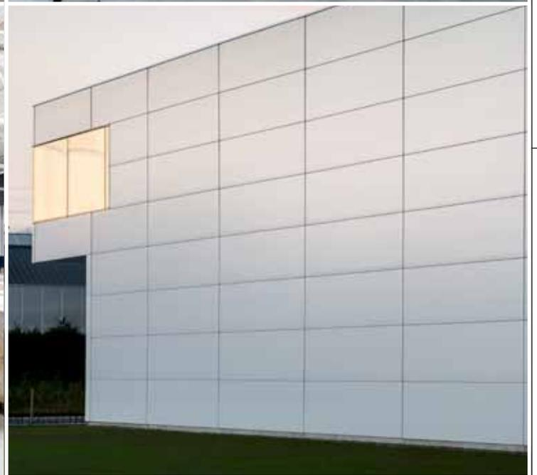
hier besteed aan de details. Voor alle hoeken en overgangstukken werden voorgevormde elementen voorzien. De voegen tussen de panelen werden zeer fijn uitgevoerd door middel van T-profielen. Voor het buitenschrijnwerk werd een nieuw type raamprofiel ontworpen, waarin het glas gelijmd wordt, zodat het perfect in hetzelfde vlak als de beplating ligt en er geen profielen zichtbaar zijn.
