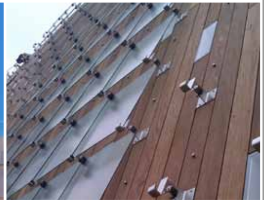
Plaatsen van het glas, inbouwen lichttunnels _Montage des éléments en verre et intégration des ouvertures lumineuses.
